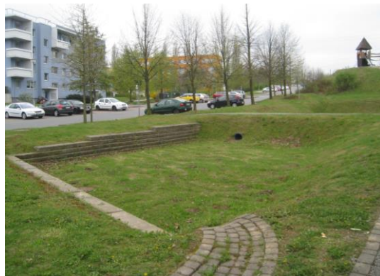
Regenwassereinleitung in eine Rasenmulde und Überlauf (S. Rößler)
