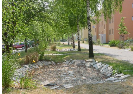
Versickerungsmulde mit Schacht (M. Hergert)
