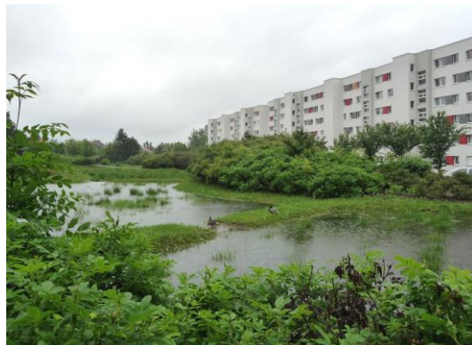
Eingestaute Versickerungsmulden im Naturpark Hetzdorfer Straße (Anschluss von ca. 4.700 m 2 Dachfläche) (M. Hergert)
