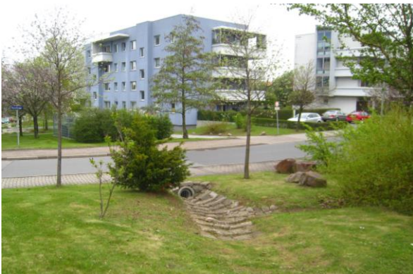
Regenwassereinleitung in eine Rasenmulde (S. Rößler)
