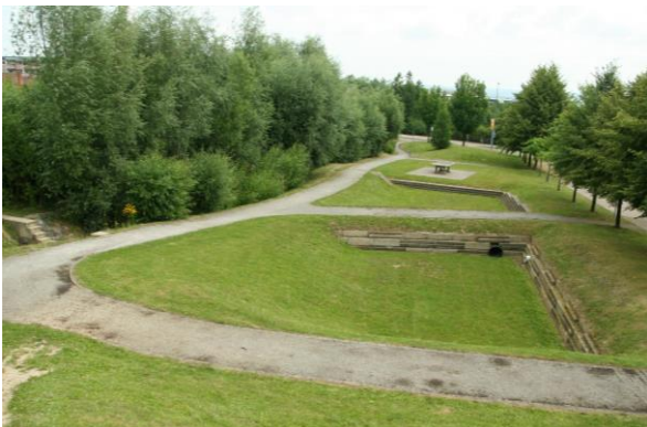
Kaskadenförmige Anordnung von Versickerungsmulden (H. Hensel)
