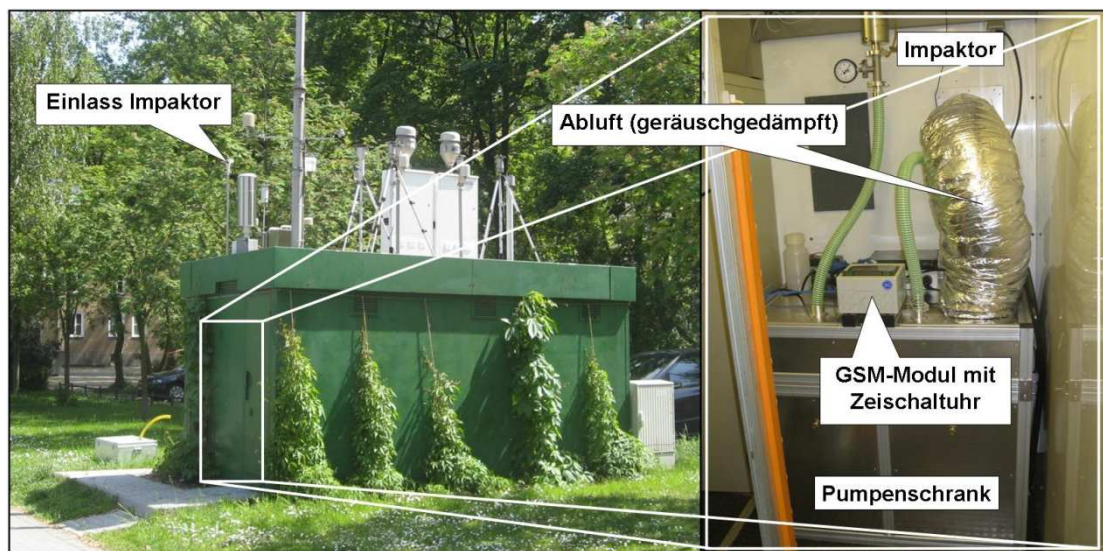
Abbildung 6: Container des LfULG in der Winkelmannstraße. Rechts eine Innenansicht mit der geräuschgedämpft eingebauten Pumpe und der geräuschgedämpften Belüftung, die einen thermisch vom Inneren des Containers abgekoppelten Betrieb ermöglicht.
